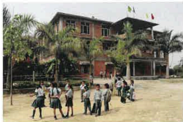
BESTEHENDE SCHULANLAGE IM ROHBAU
